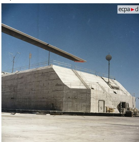
Bunker du poste d'enregistrement avancé (PEA) du CEP Dindon à Moruroa.
