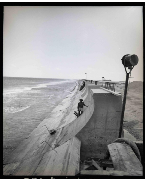
Doc 8. Construction de la digue de protection du port de Papeete , 1965
